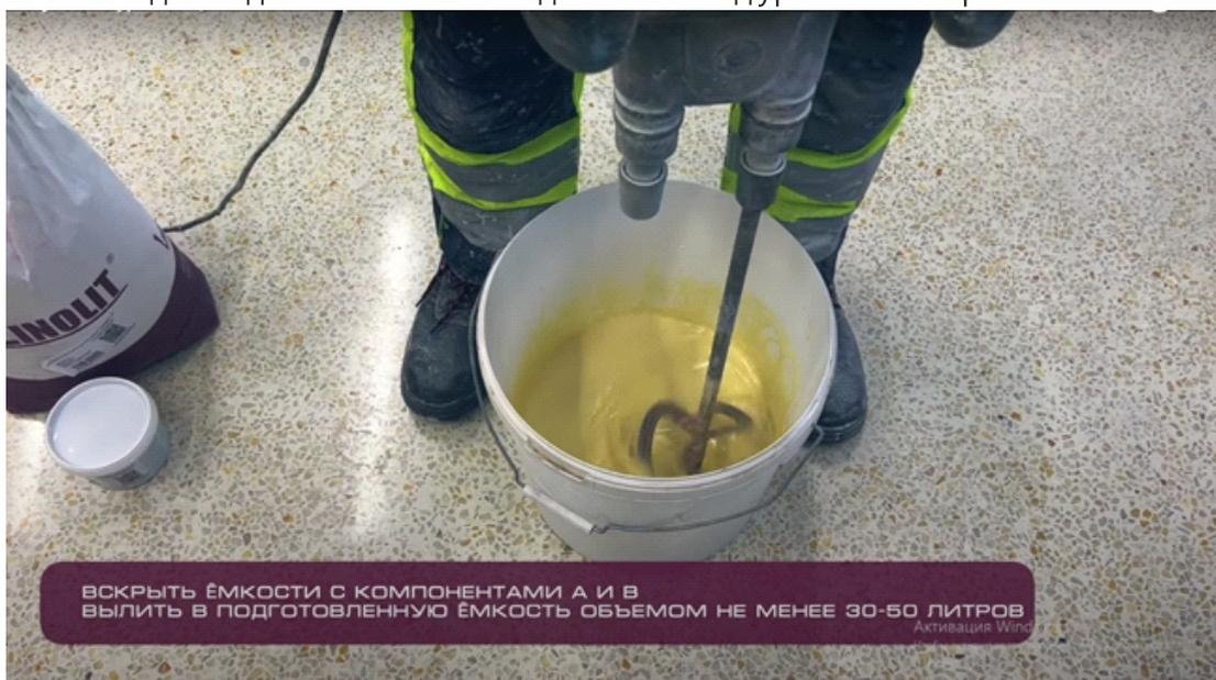
2. Постепенно внести наполнитель (компонент С) в смесь, мешать в течение минимум 3 минут до полного перемешивания и получения гомогенной (однородной) смеси. Рекомендуемое время смешивания 2-3 минуты. Особое внимание следует уделять тщательному перемешиванию материала в зоне дна и стенок ведра во избежании дефектов покрытия (плохо перемешанные компоненты и комки сухой смеси не полностью вступают в химическую реакцию).
