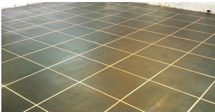
Самоклеящуюся медную ленту необходимо клеить по оштукатуренной поверхности после окончания процесса полимеризации грунтовочного состава LINCRETE® P100. Лента клеится по контуру помещения (на расстоянии не более 0,1 м от стены или края помещения) и далее по поверхности с шагом (клетками) 1,5 – 3,0 м (в зависимости от конфигурации помещения).
